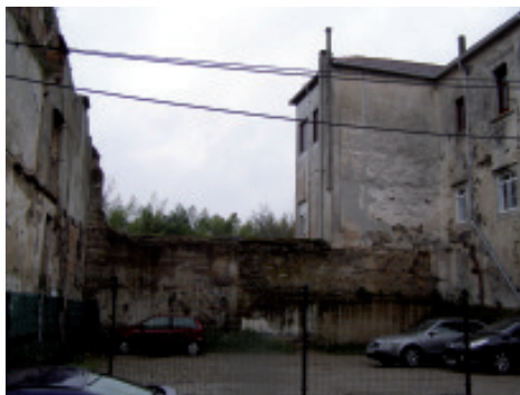
16.- Fachada trasera del edificio, donde se observa el muro de mampostería de pizarra que limita el huerto del desaparecido convento con las viviendas de la actual calle San Francisco. El acceso a las caballerizas de la vivienda de Don Germán Etcheverría Vila se realizaba a través de un paso que existía en la parte trasera del edificio.
